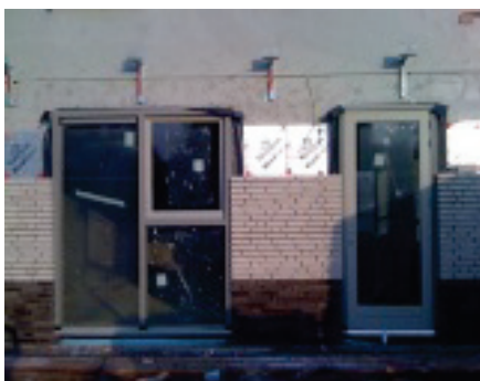
Aanpassing raamontwerp beganegrond woningen zodat het raam open kan.
